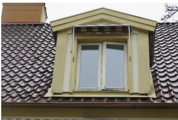
En av villans takkupor, tilläggsisolerad och med bytta fönster (jämför med bild från år 1951).
