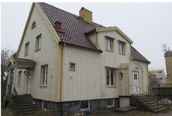
Villans västfasad med fronton och köksentré.
