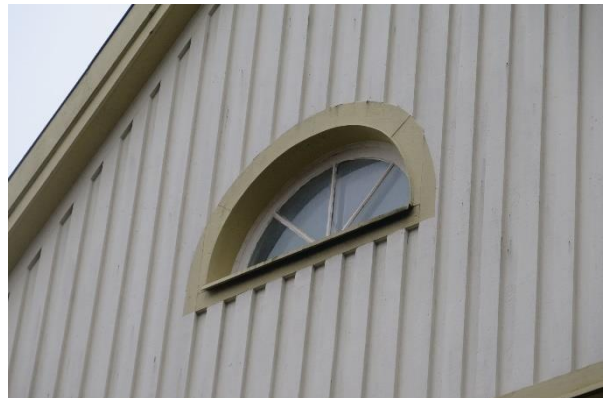
Ett av två ursprungliga lunettfönster i trä till vinden.
